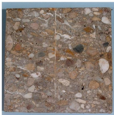
Béton renforcé de fibres FIBRAFLEX Aspect après 15 mois
